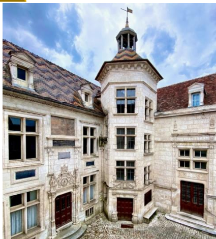
La cour intérieure de l'hôtel d'Uzès et sa tour d'angle.
